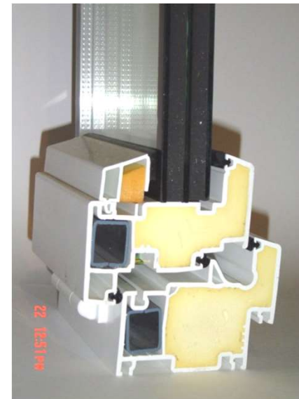
gedämmte Profile 0,75-0,85 W/m 2 K
